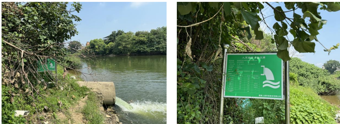
图 3.1-2 现状入河排污口及标示牌
