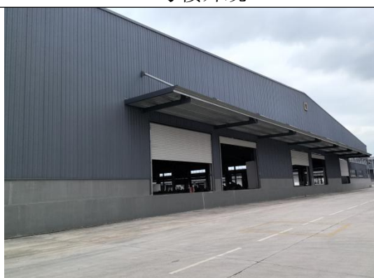
周边的钢结构厂房
